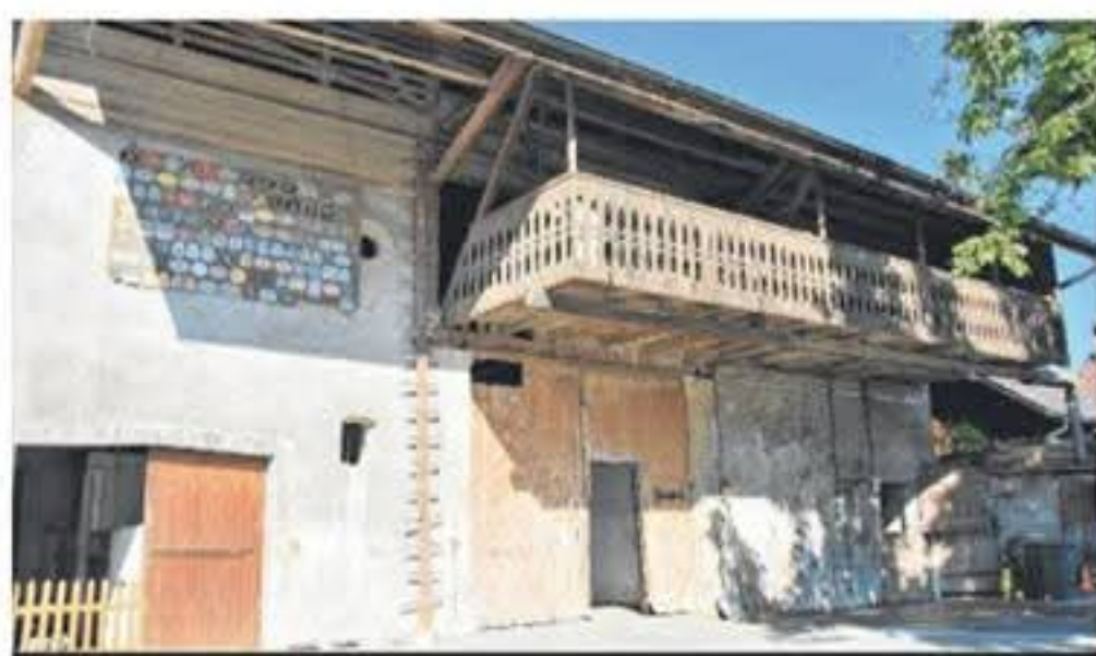
Aménagement de box à chevaux à Mènières, sans dénaturer la façade extérieure.
