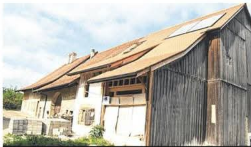
Extérieur d'un rural à Aumont, avant les travaux de rénovation.
